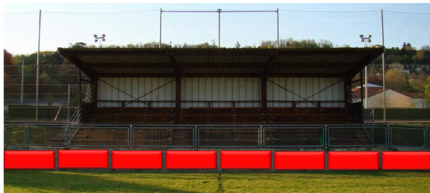
Périphérie côté tribune sur mur latéral
